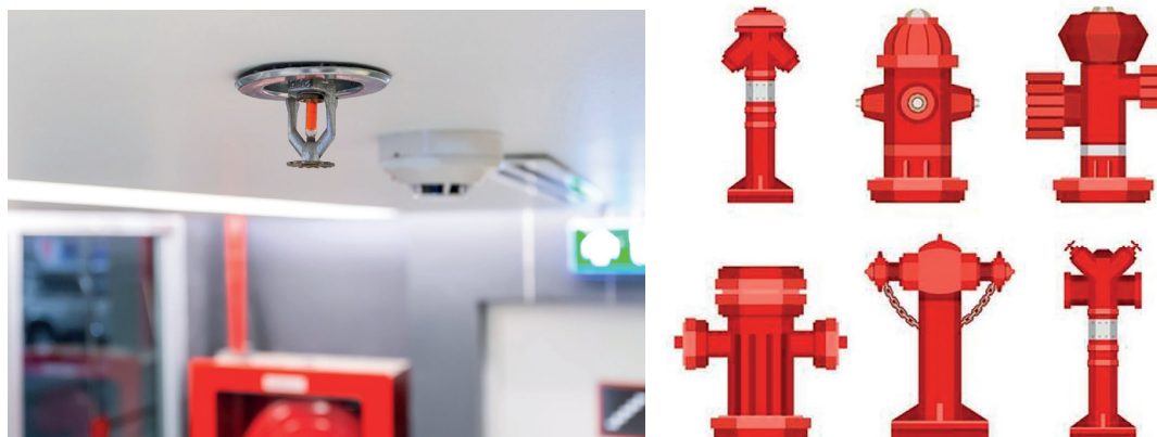
Fig. 2. Rociadores automáticos o sprinklers (izda.). Tipos de hidrantes (dcha.).
