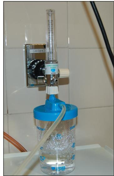
Fig. 4. Toma de  $O_2$  de pared.
